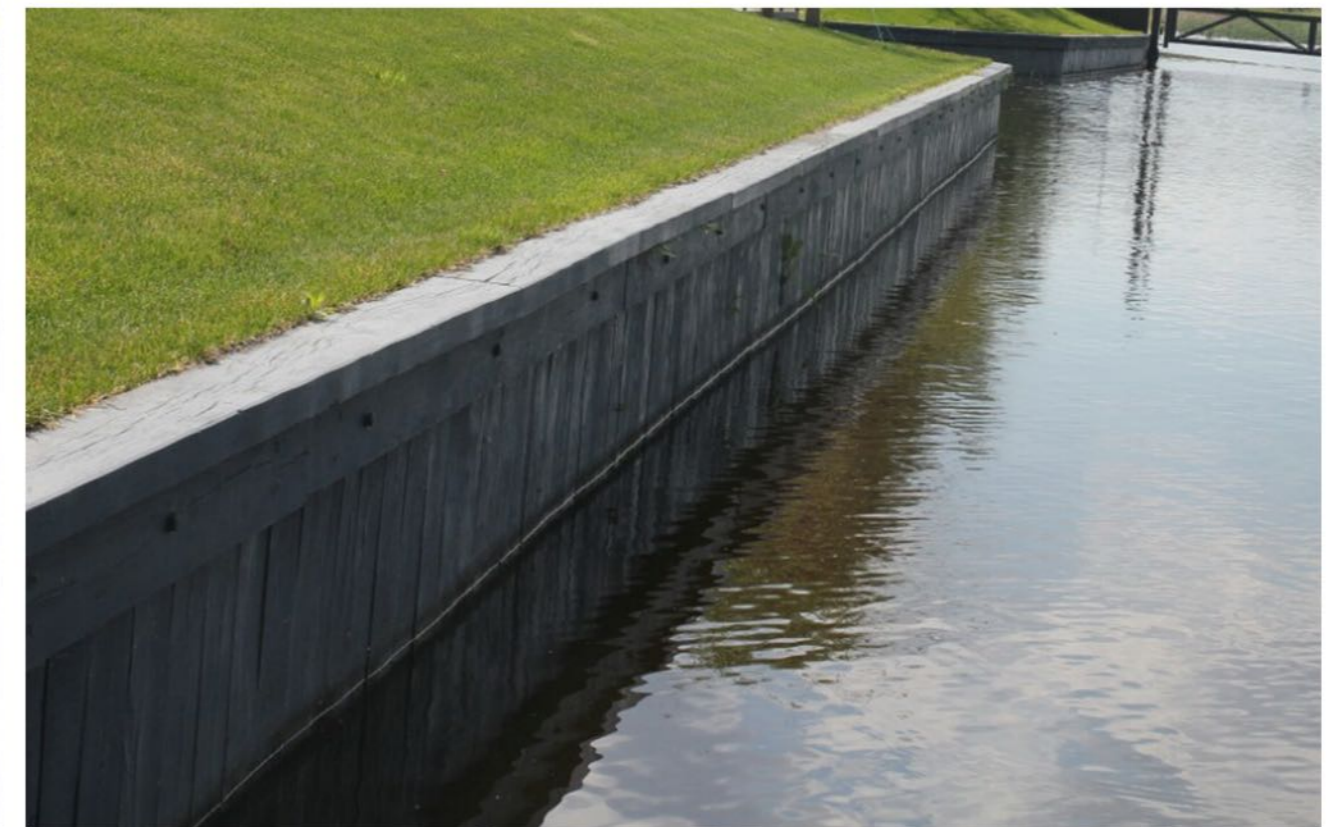
Підпірна стінка В3 (залізобетонні стіни)
